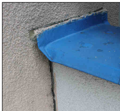
OBR. 2 – UTRŽENÁ ZÍDKA ZÁBRADLÍ
