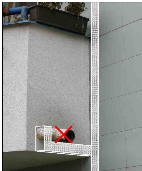
OBR. 5 – ODVOD VODY Z BALKONU
