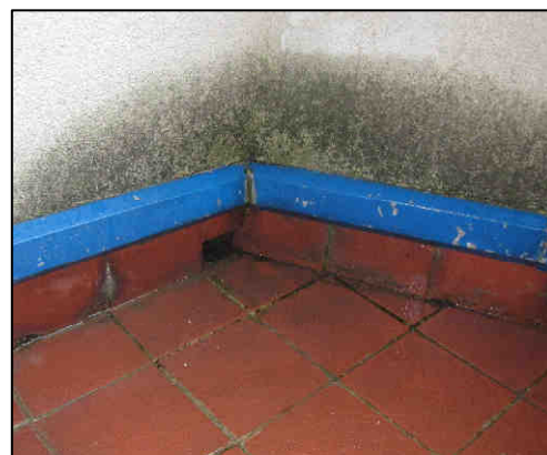
OBR. 3 – MOKRÁ ZÍDKA ZÁBRADLÍ
