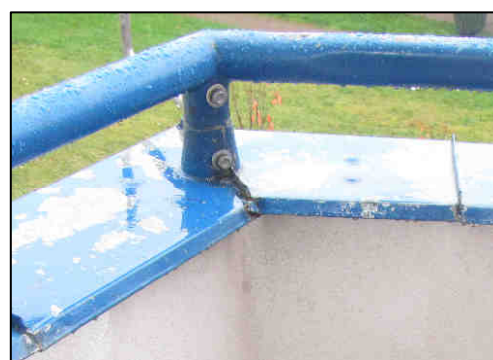
OBR. 2 – UTRŽENÁ ZÍDKA ZÁBRADLÍ
